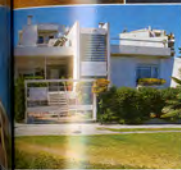
Κατοικία στην Αδρια- νουπόλεις και Πλα- τωνος. Αρχιτέκτονες: Κ. Φυλίνου. Ανακαινί- σθηκε πρόσφατα από τον αρχιτέκτονα κ. Α. Μπαλοκονάκη.
